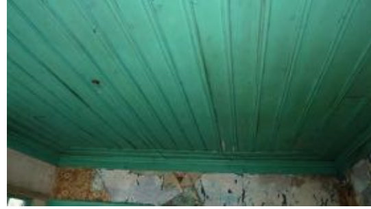
Şekil 7. 201 nolu odada yer alan yüklük ile çıtalı tavanın görünümü
