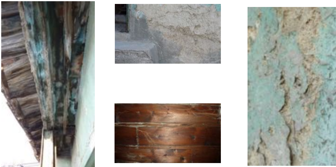
Şekil 14. Yapıda farklı malzeme sorunları
