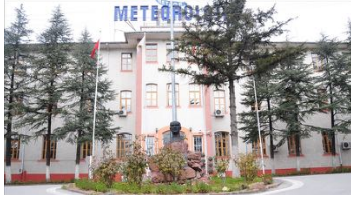
Resim 16 Meteoroloji Genel Mudurlugu Binası
